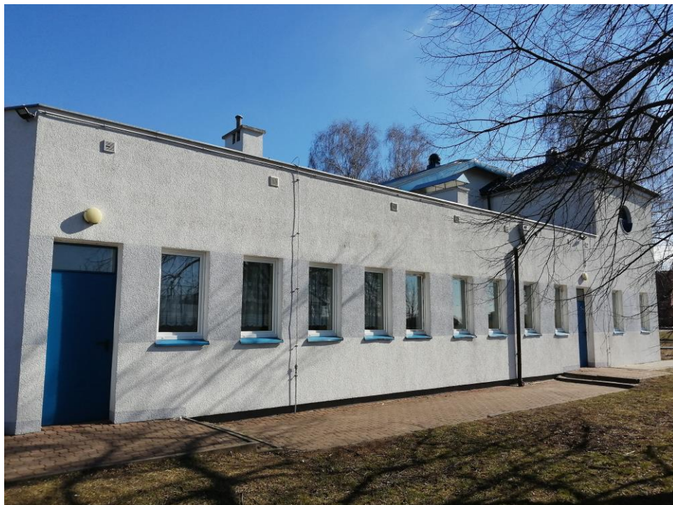
Fot. 5. Modernizacja sali wiejskiej w Skoraszewicach – nowe okna
