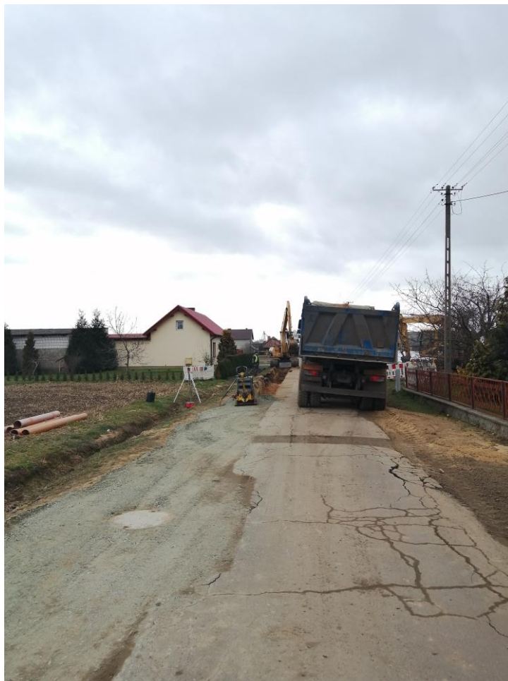
Fot. 2 i 3. Budowa sieci kanalizacji sanitarnej w Krzyżankach - etap IIB
