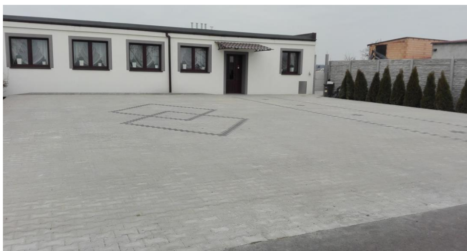
Fot. 14. Nowa nawierzchnia parkingu przy świetlicy wiejskiej w Kościeszkowie
